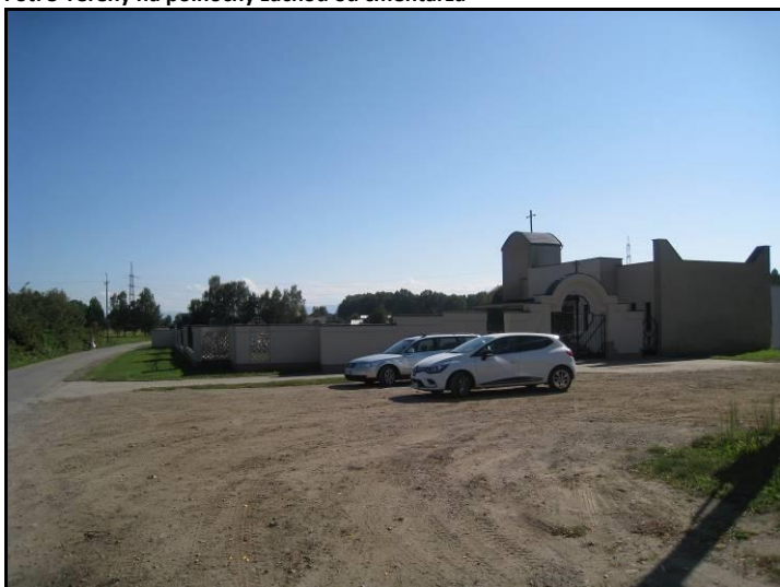
Fot. 6 Cmentarz wraz z kaplicą widziany od strony ul. Bieruńskiej
